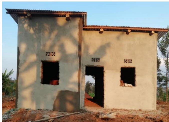
Het nieuwe huis in aanbouw
